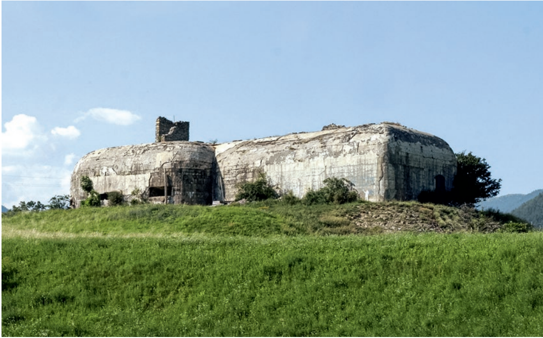
Abb. 1: Freistehender Bunker, Mals
