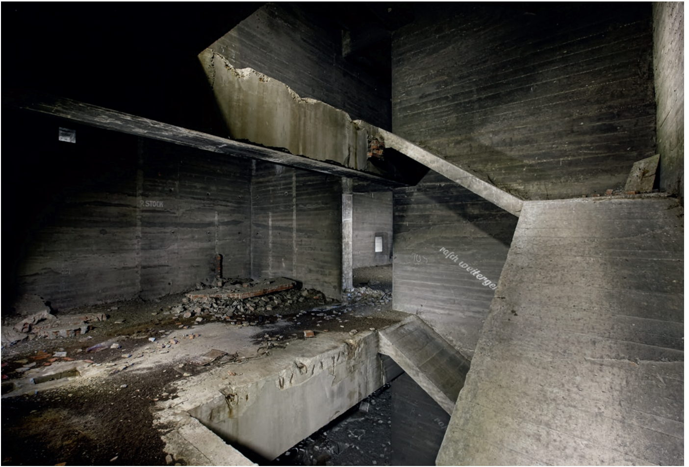
Abb. 5: Ehemaliger Leitturm Augarten: Innenansicht 2014
